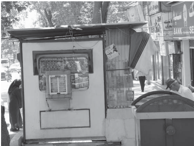
نمونه ای از کیوسک های موجود تهران (نصب ایرانیت در سقف، نصب تجهیزات و متعلقات اضافی)
